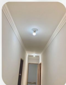
Molduras em Gesso
