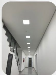
Forro em Drywall
